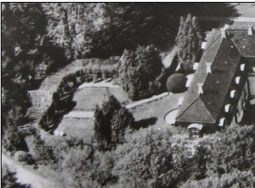
Figur 15. Detalj av vykort visande pergolan. Bilden förmodligen från 1940-talet.
