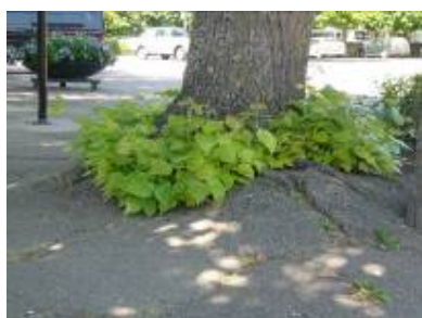
Figur 4. Asfaltssprängning. Fotot från maj 2006
