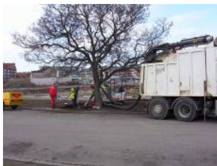
Figur 23. Här syns schaktning med hjälp av en mobil vakuumlastare.
