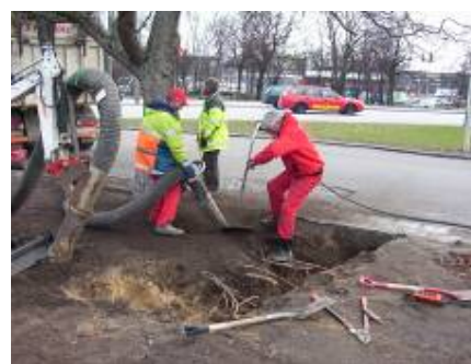
Figur 24. Via kraftigt undertryck skapas en luftström som suger in jordmassor.
