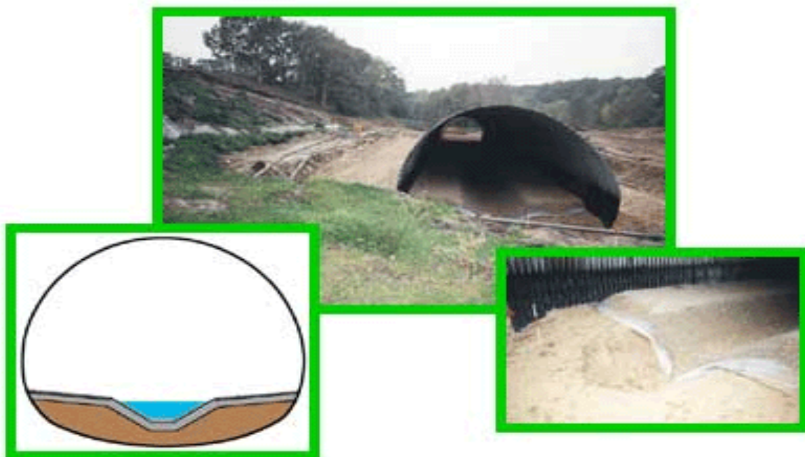
Anläggning av rörbro med viltpassage
