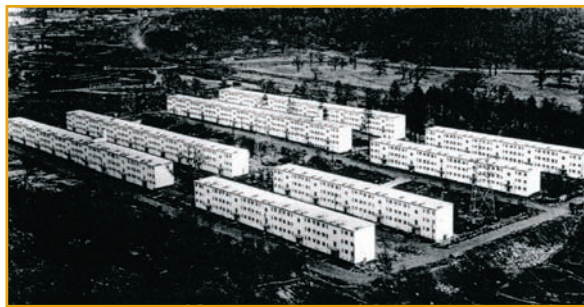
I Stockholm byggdes 25 000 lägenheter i smalhus mellan åren 1934–1946. Fotografiet visar de första smalhusen "Abessinien", som byggdes i Hjärtan av byggmästare Olle Engkvist (1934–37). Arkitekt var Hakon Ahlberg. Husen är orienterade i öst–väst för att släppa in maximalt med ljus till de genomgående lägenheterna. Fotografi ur Arkitekturmu-seets arkiv.
