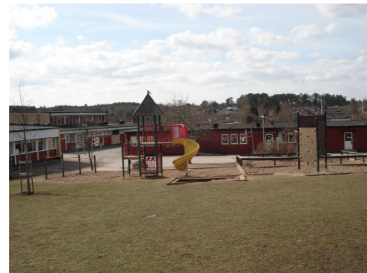
Bild från kullen mot klassrummen för årskurs två och tre. En av klätterställningarna på Vidingsjöskolan. Foto: Ireman 2008
