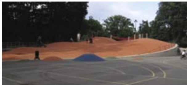
Figur 21 Artificiella kullar i gummiastfalt.
