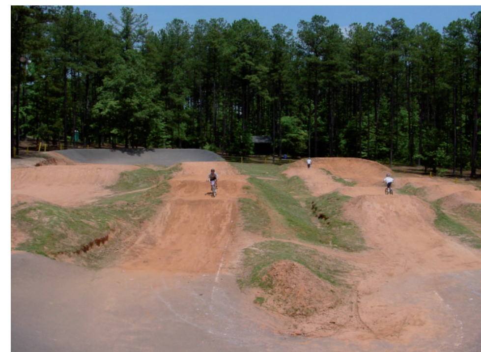
BMX-bana uppbyggd av överskottsmassor, USA.
