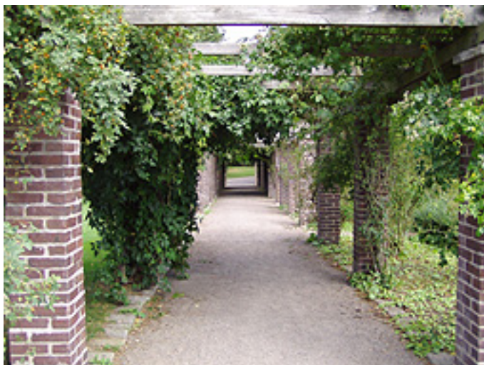
Pergolan i Slottshagen, likt Stureholms pergola uppförd i Helsingborgstegel. (Foto: Åse Brunnström, 2003)
