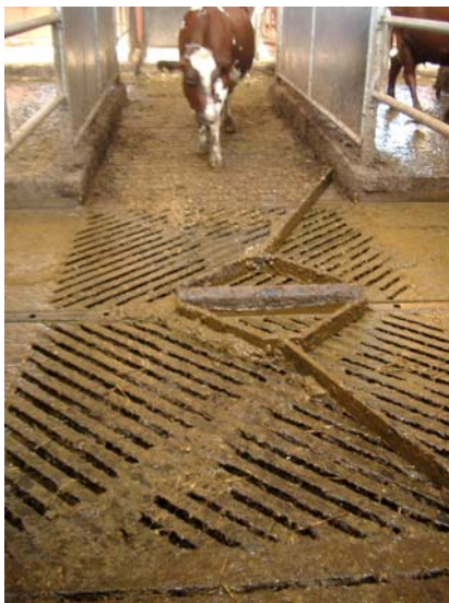
Figur 8-4 Kulvertgaller på Dansjö gård.
