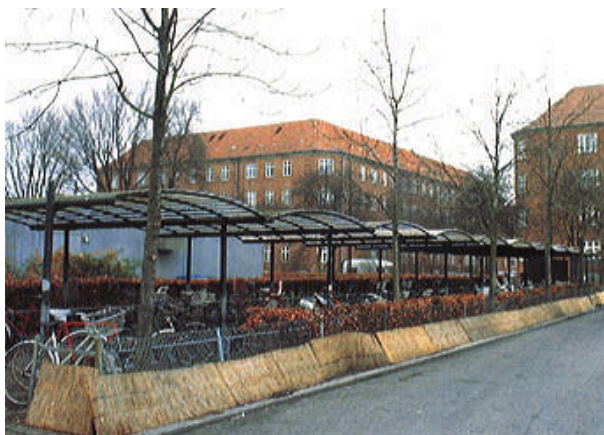
Figur 4. Saltstänkskydd med plastbeklädd halmmatta, i Köpenhamn. Fotografiet taget från Vejsalt, træer og buske, Rapport nr. 64, Vejdirektoratet (uå).
