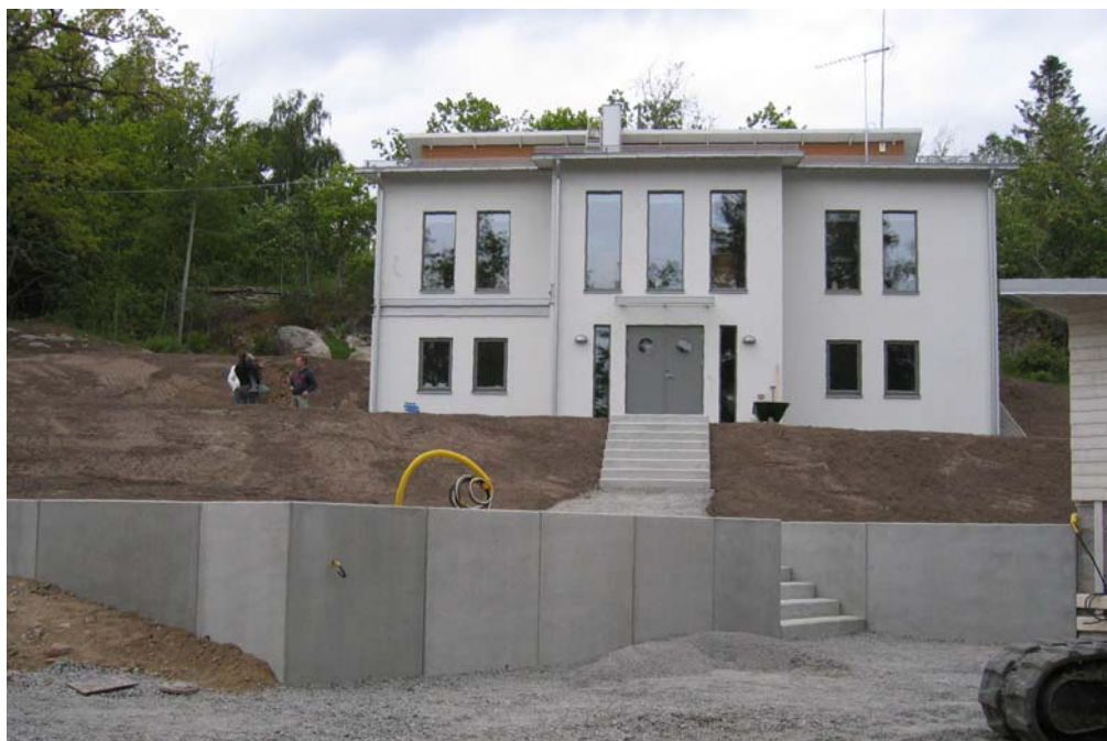
Bild 5 Villa Berg sett från Backsippevägen. Fotot är taget innan bygget av altanen påbörjades.
