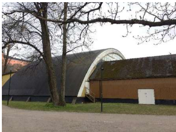
Figur 18 – Bilden visar baksidan av "Svettis" med slitna tak och kala väggar. Foto: Linnéa Gustafsson, 24 april 201.
