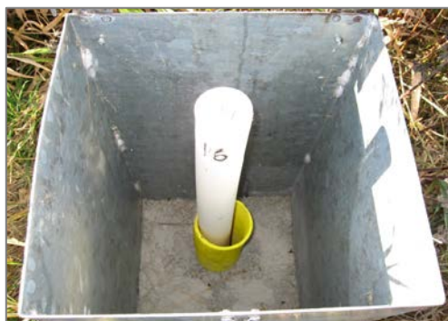
Figur 6. Grundvattenrör. Foto: Maria Blomberg
