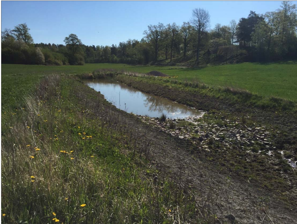
Figur 7. Fosfordamm i Västerviks kommun. Dammen har en djupare del för sedimentation vid inloppet och en grundare översilningsyta vid utloppet. Foto: Katarina Kyllmar.
