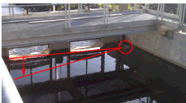
Figur 10. Placering av den tredje Simsonarutrustningen för registrering av fisk vid den östra spillluckan, till vänster i bild. Foto Pertti Paakkolanvaara. Den högra figuren visar området som skannades av kameran där överkanten av bilden motsvarar vattenytan. Luckan närmast kameran var för nära för att med säkerhet kunna registrera passerande smolt.
