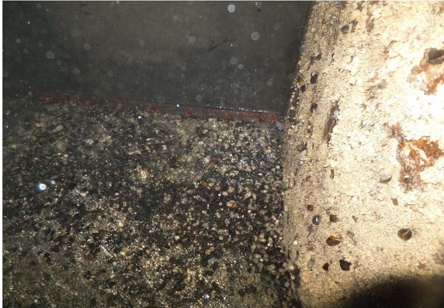
Figur 2. Golv och vägg vid intagsportarna i den norra tunneln.
