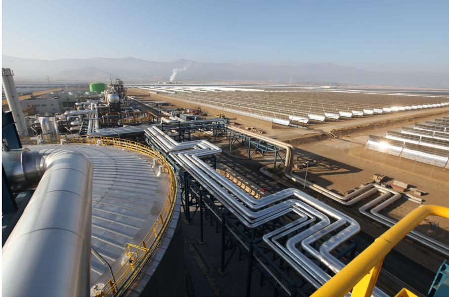
Abbildung 4.2.1: Bild des Kraftwerks Andasol III. Dieses Kraftwerk weist viele Ähnlichkeiten zu Andasol I auf. Im Vordergrund auf der linken Seite ist der thermische Salzspeicher zu sehen. Im Hintergrund sieht man die Parabolspiegel. Es lässt sich erkennen, wie die Spiegel in Loops aufgestellt sind. Das Bild ist aus der Pressemitteilung zur Eröffnung des Kraftwerkes entnommen [RWE11].
