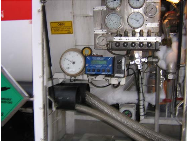
Figur 9. Utrustning på tankbilen för registrering av gasflöde etc. I stalllet på Gård 3 tillfördes c:a 3560 kg koldioxid.
