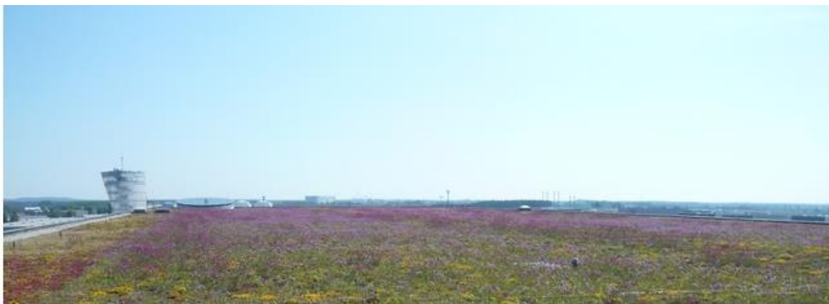
Abbildung: Messstandort (Gründach) am Flughafen Berlin Brandenburg.
