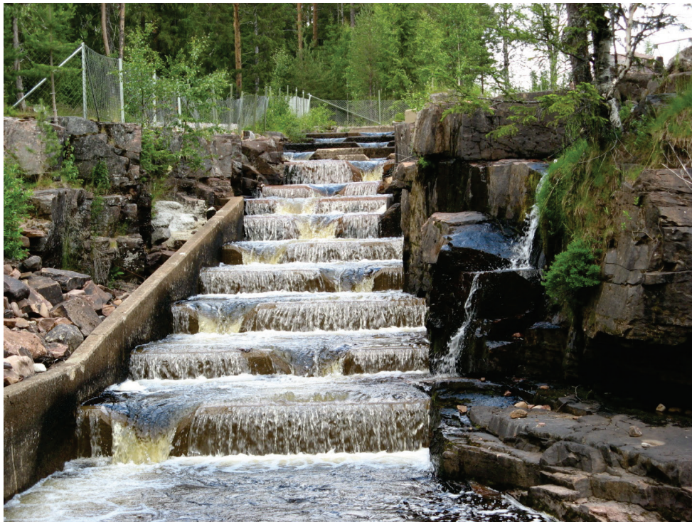
Fisktrappan i Fjätälven. Trappan anlades 1960 och restaurerades 2004 då bl.a. en fälla installerades för att möjliggöra räkning och provtagning av passerande fisk. Foto: Evert Spånberg.
