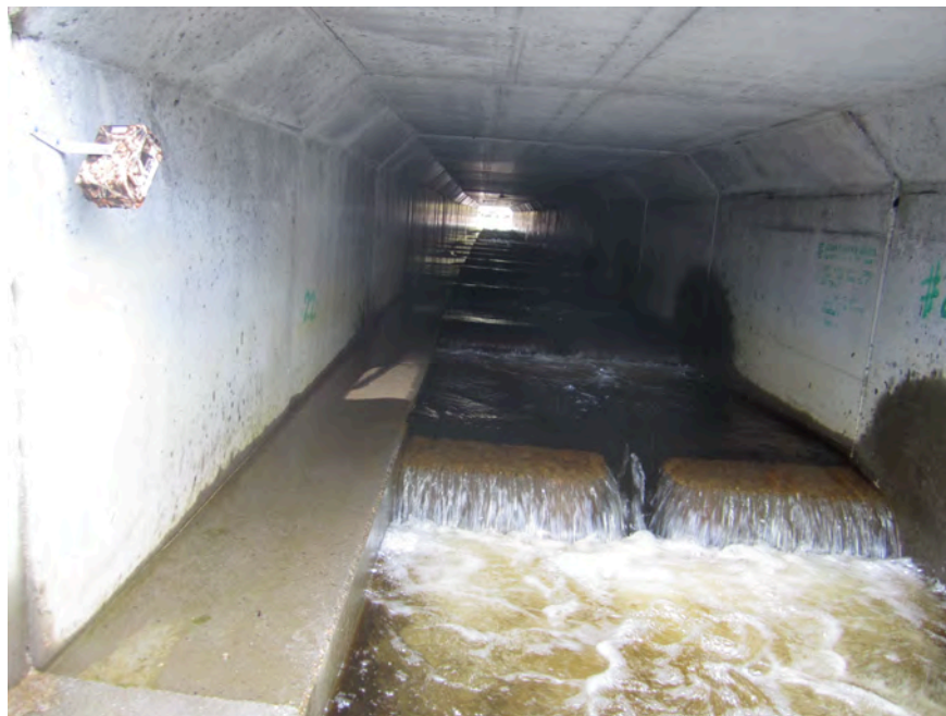
Figure 2.4 Les quatre types de passage faunique conçus pour les mammifères de petite et moyenne taille le long de la route 175 : ponceau avec une banquette de béton (PBBét) (Photos: Université Concordia)
