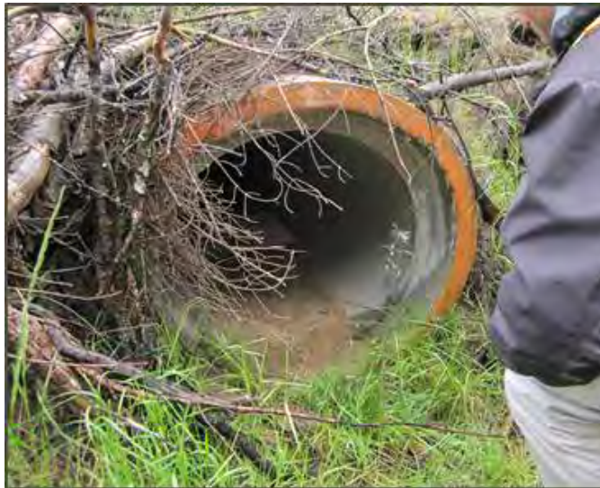
Figure 2.1 Les quatre types de passage faunique conçus pour les mammifères de petite et moyenne taille le long de la route 175 : ponceau sec (PS) ou tuyau circulaire (Photos: Université Concordia)
