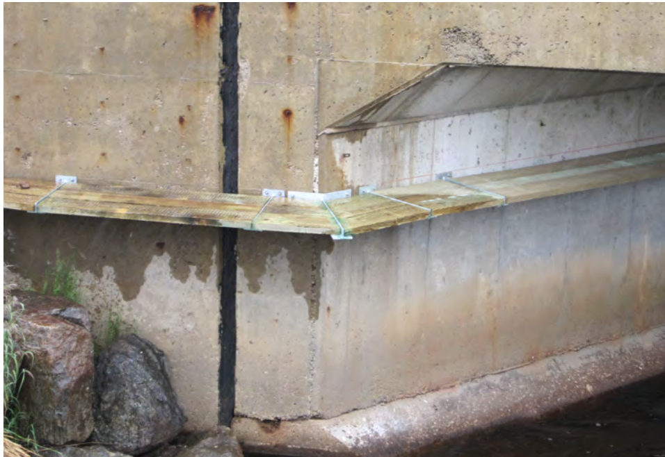
Figure 2.2 Les quatre types de passage faunique conçus pour les mammifères de petite et moyenne taille le long de la route 175 : ponceau avec tablette de bois installée en porte-à-faux (PTBois) (Photos: Université Concordia)
