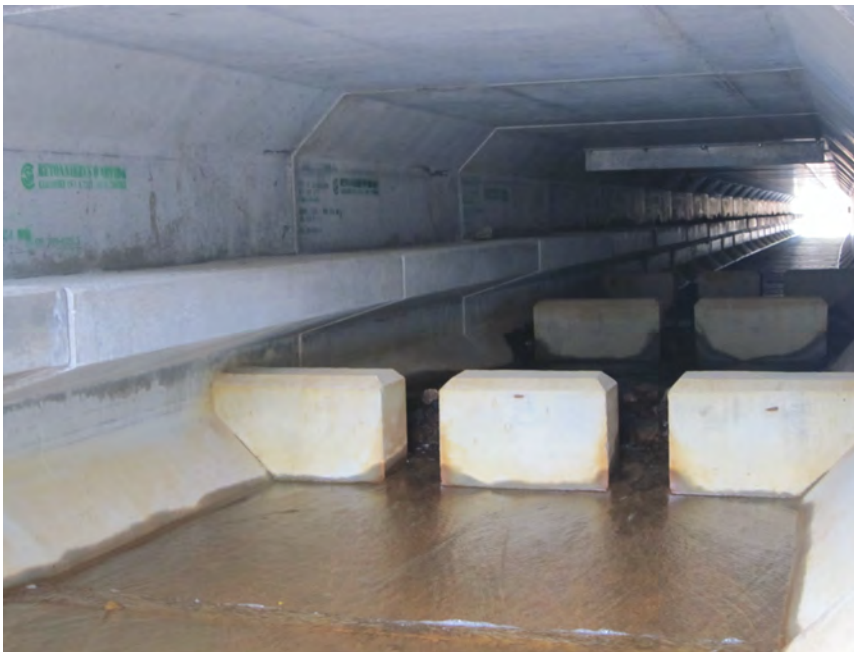
Figure 2.3 Les quatre types de passage faunique conçus pour les mammifères de petite et moyenne taille le long de la route 175 : ponceau avec pied sec de type tablette de béton (PTBét) (Photos: Université Concordia)
