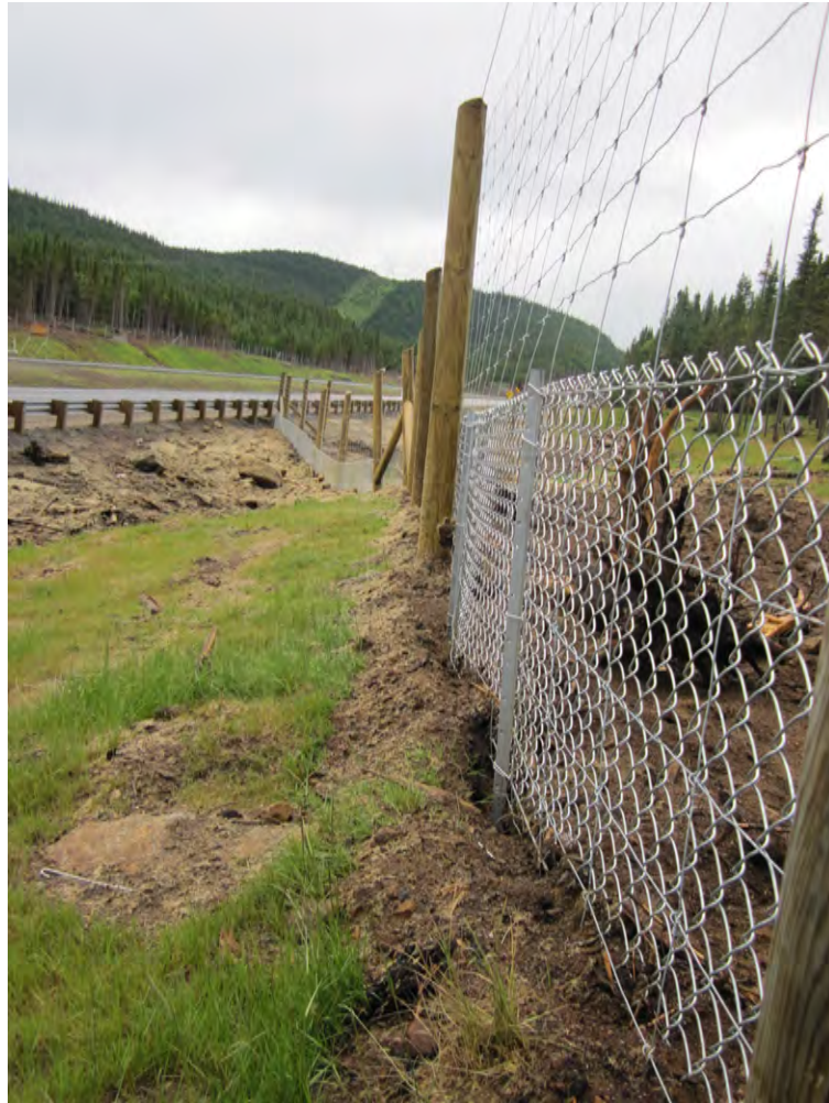
Figure 3.1 Clôture à grande faune (en haut) et clôture pour la faune de taille moyenne (en bas) (Photo: Université Concordia)
