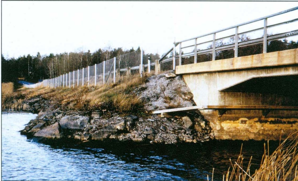
Figure 5.5 Exemple de tablettes en bois que la faune peut utiliser afin de se déplacer sous un pont. Des clôtures ont été installées le long de la route (Source : G. Hammar)
