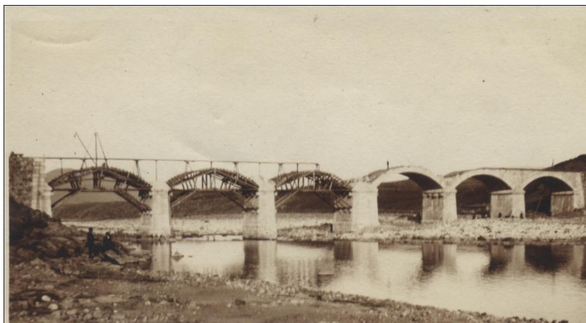
98. El Barco de Ávila. Puente Nuevo sobre el Tormes. 1904
