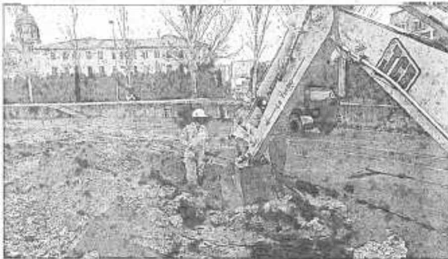
DEMOLICIÓN. Las máquinas comienzan a reducir la estructura, pasado el fútbol y la sede de los embalses de agua.
