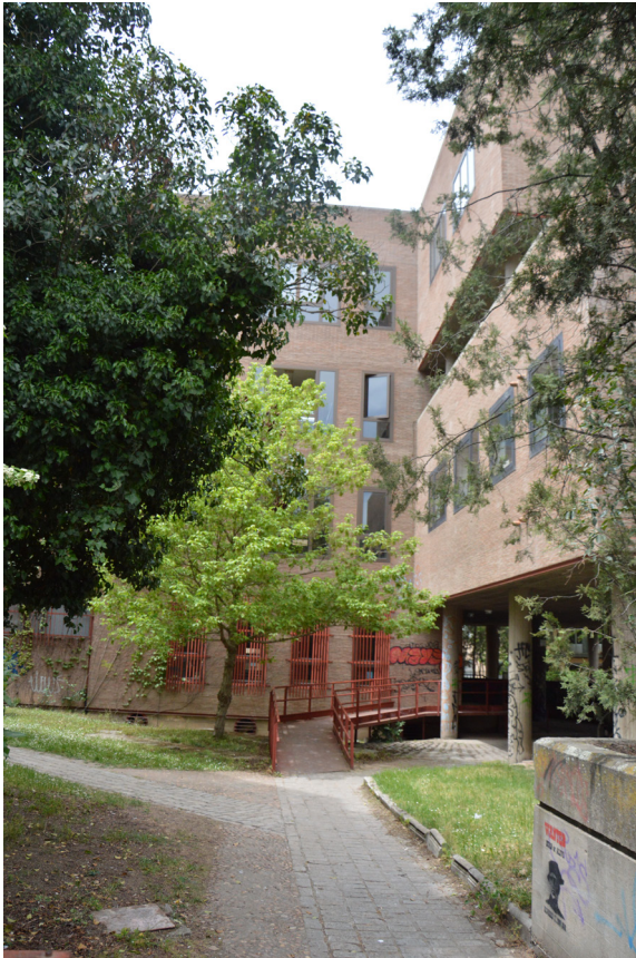
Acceso al edificio de ampliación
