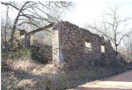
Figura 4. Linares de Riofrío. Almacenes.
