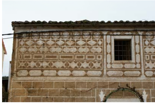
Figura 29. Tamames de la Sierra. Edificio de principios del siglo XX.
