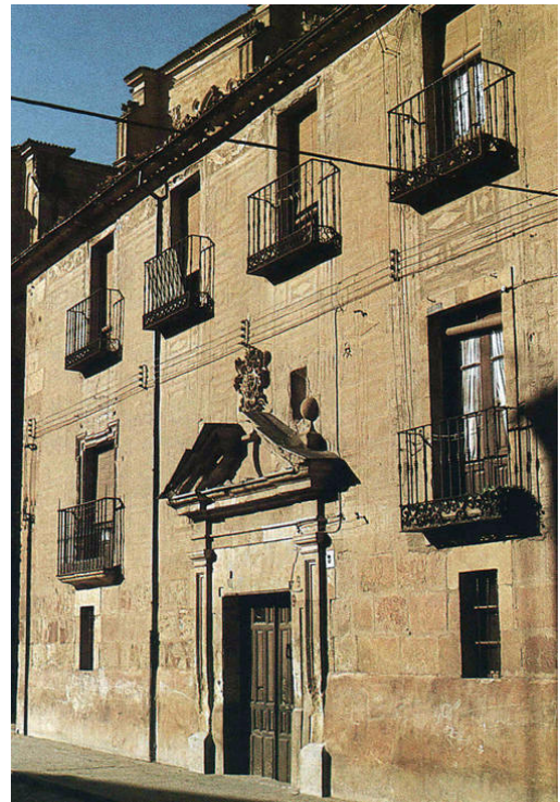
Figura 54. Fachada antigua esgrafiada del Colegio Santa Catalina.
