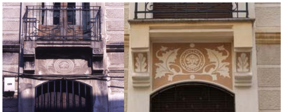
16. Fachada de la calle Travesía, antes y después, esgrafiada y posteriormente pintada.
