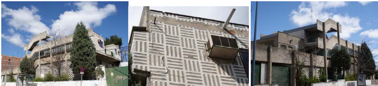
Figura 53. Fachadas y detalle del estado actual de la fábrica de Pontvianne.
