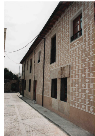
Figura 39. Fachada terminada. La diferencia de tonalidades es debida a la falta de tiempo de fraguado.
