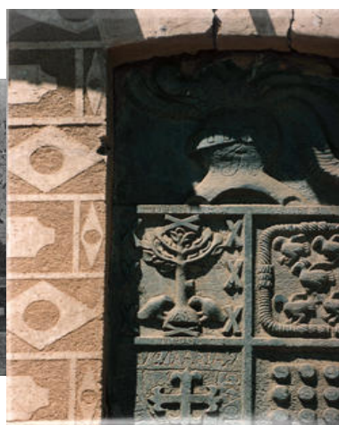
Edificio en Salvatierra de T.
