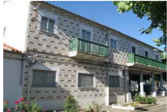
Figura 51. Vista general entrada a la plaza.
