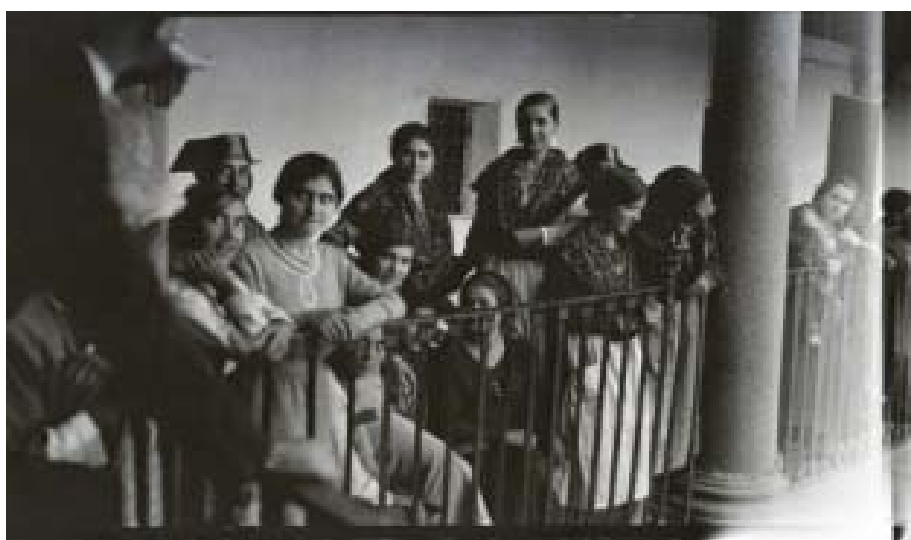
Fig. 7. Una de las fotografías tomadas por Schindler
