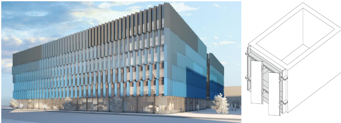
Figur 31 Konceptritning för det vinnande bidraget i studenttävlingen på Chalmers. Vertikalt orienterade vridbara PV-moduler används som solavskärmningar
