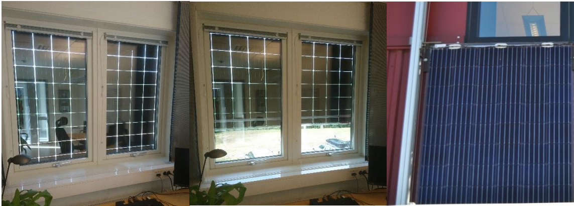
Figur 13 Den vertikala avskärmningen med transparenta glas-glasmoduler
