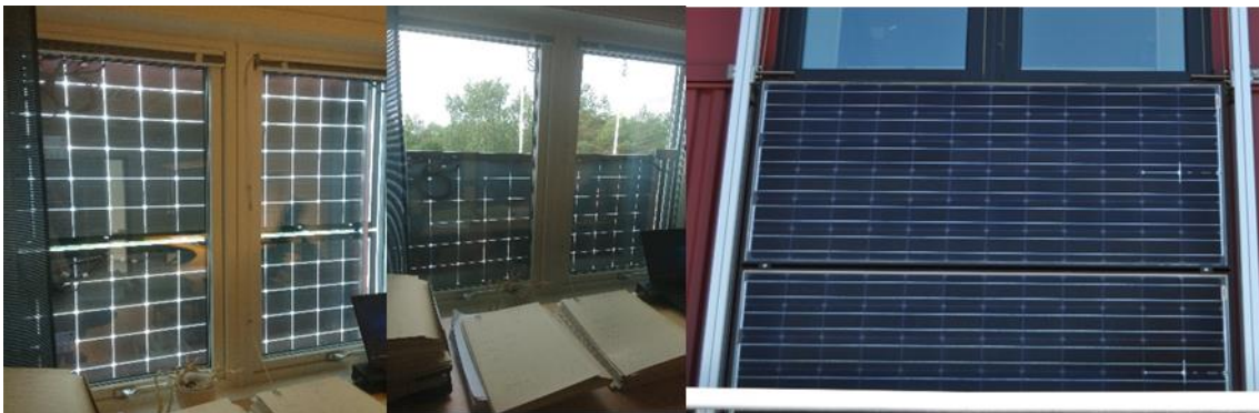
Figur 14 Den vertikala avskärmningen med liggande moduler och baksida av transparent tedlar
