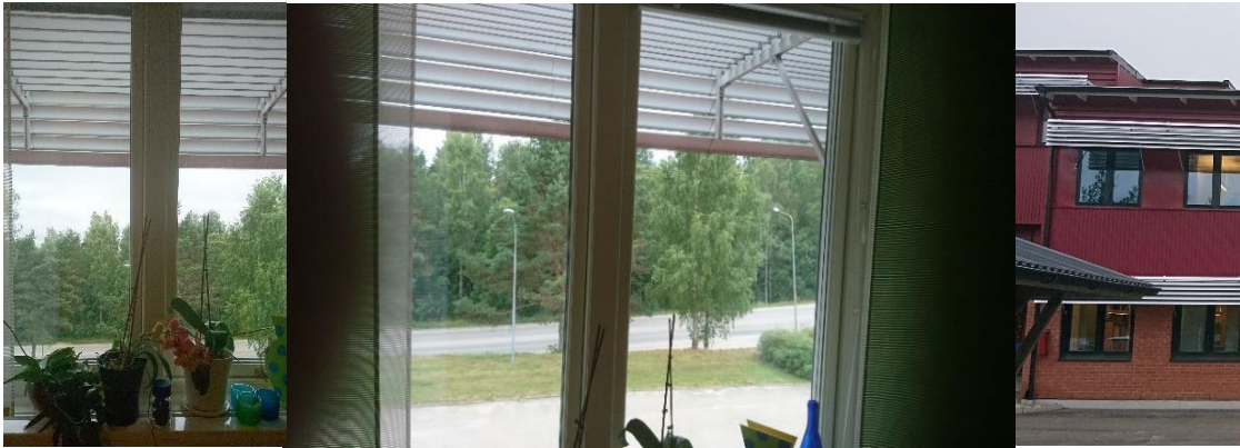
Figur 12 Den ordinarie solavskärmningen på RISE kontorsbyggnader består av aluminiumlameller i ett horisontellt och vertikalt arrangemang. Utsikt från sittande och stående vid skrivbordet
