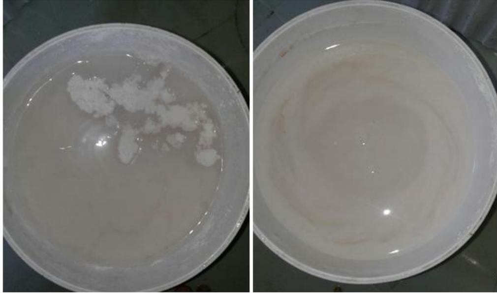
Figura 11: Preparación de agua con cal para curado
