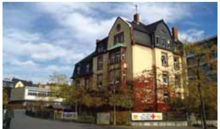
Erfreuliche Verwandlung: Bis Anfang 2014 wird das ehemalige Wohnhaus im Zentrum des Campus Nibelungenplatz zu einem forschungsorientierten Kinderhaus umgebaut.
