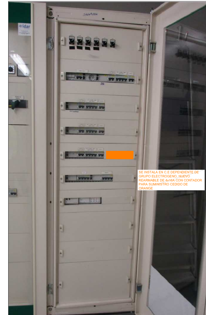
DETALLE REARMABLE CEDIDO POR IKEA EN C.E. DEPENDIENTE DE GRUPO ELECTROGENO
