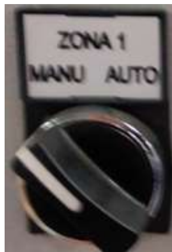
Figura 3.10 Llavín automático/manual
