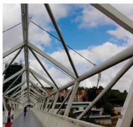
Figura 3. Pasarela del Museo de la Ciencia. Detalle del pretensado perimetral en el vano 3.
