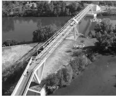
Figura 3. Vista general de la estructura en estudio.
