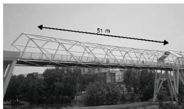
Figura 4. Vista del Vano 2.
