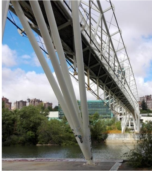
Figura 2-6. Pasarela del Museo de la Ciencia (Valladolid). Vista del vano principal.
