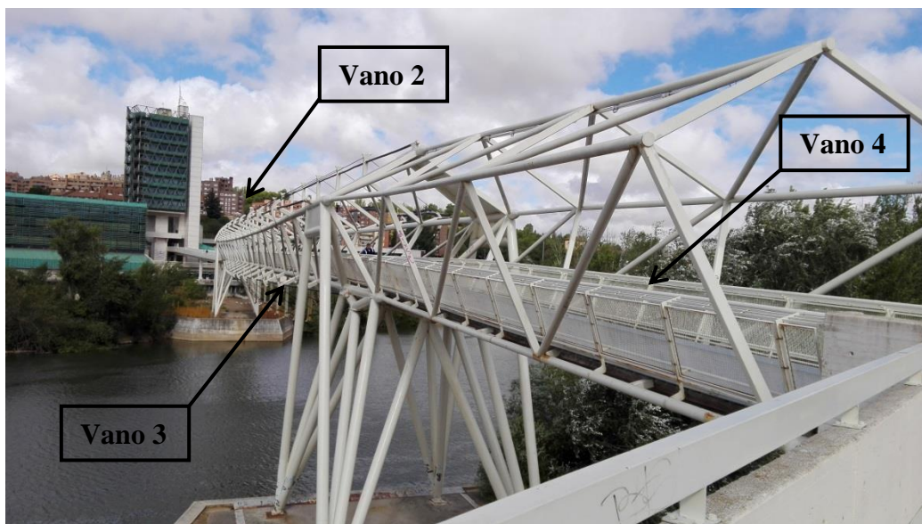
Figura 2-5. Pasarela del Museo de la Ciencia (Valladolid). Vista general.
