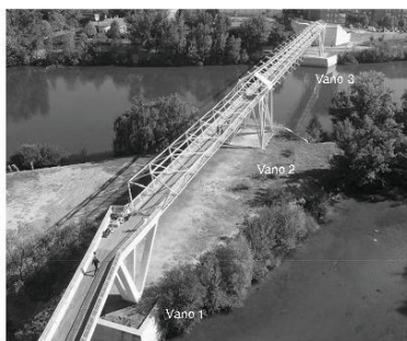
Figura 3. Vista general de la estructura en estudio.
