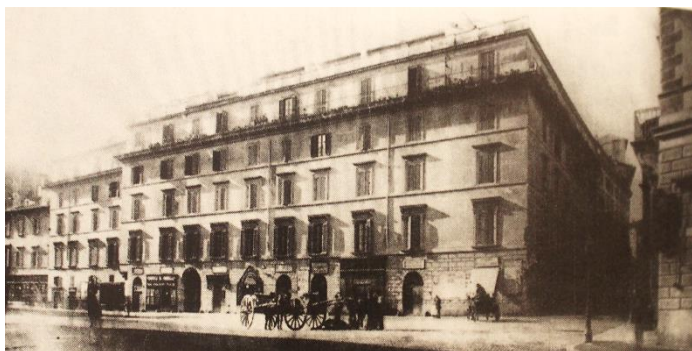
Imq. 11. Palazzo di Cesarini antes de la demolición.
