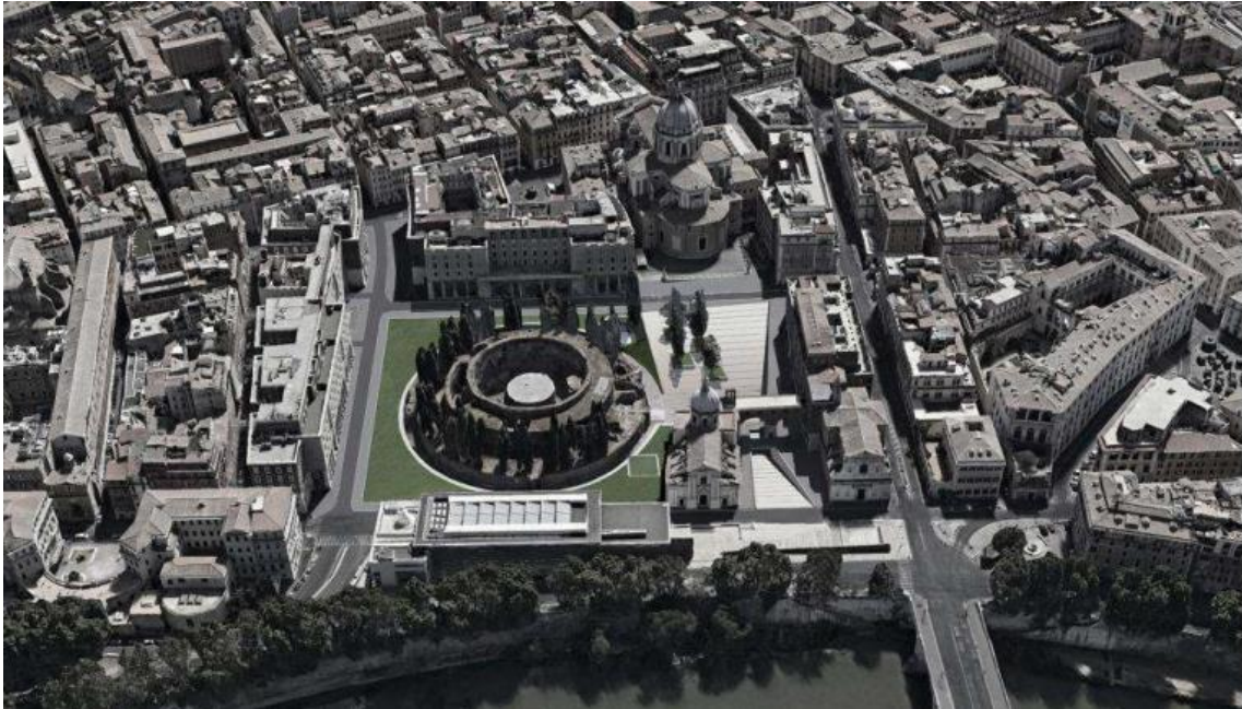
Img. 33. Vista del proyecto donde vemos el contexto donde está ubicado y las vías y accesos que tiene por los diferentes lados.
