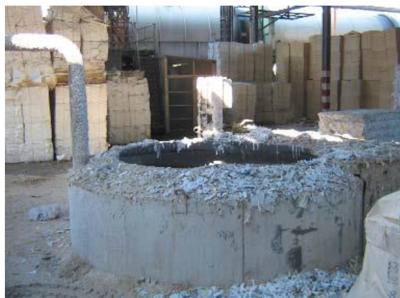
Figura V.3.1: Púlper con protección en su perímetro
