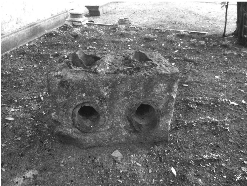
Fig. 2. Codo de las conducciones de la traída de agua de los manantiales de Argales a Valladolid, procedente de la Plaza de España (Valladolid). Siglos XVI-XVII. Actualmente en el Museo Nacional de Escultura. Valladolid. Fotografía de Cristina Heredia Alonso.
