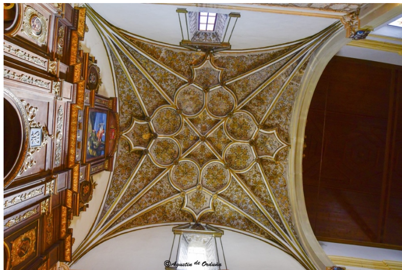
Fig.4. Bóveda estrellada de la Capilla Mayor.
