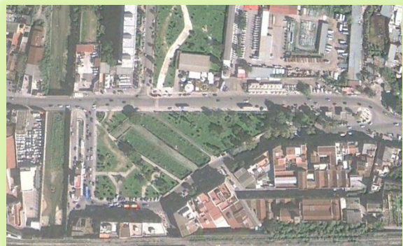
Fig. 61 vista aérea zona puente del almirante. Estado del área de actuación en 2010. Fuente: google earth
