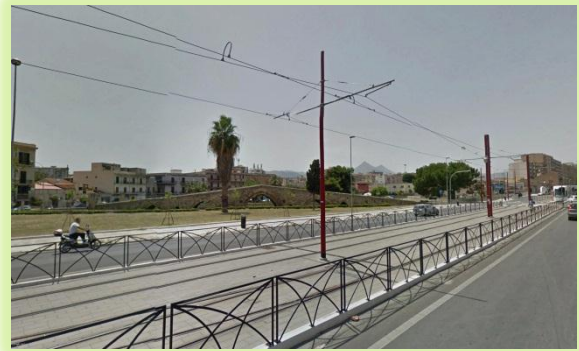
Fig. 60 intervención realizada en la via colindante al puente del almirante. Fuente: google earth
