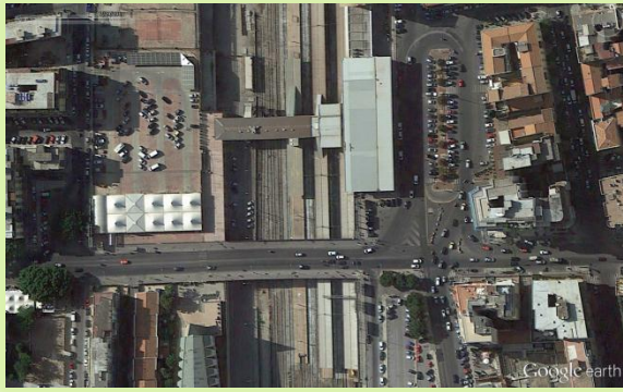
Fig.65 vista aérea estación Nortarbartolo, año 2012. Fuente: google earth .
