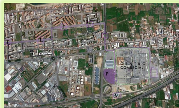
Figura 55, fuente de elaboración propia. Foto aérea (googlemaps 1/05/2015) del centro comercial donde se observa la infraestructura tranviaria con sus diferentes paradas, la estación del metro, el aparcamiento de intercambio modal y mas hacia el este el deposito de los vagones del tranvia.
