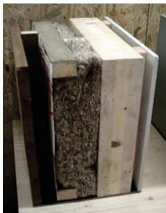
33. Detalle de fachada ventilada de CLT
