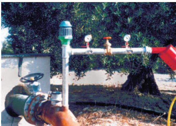
Figura 30. Ventosa bifuncional colocada a la entrada del cabezal de riego. (Centro de Formación Agraria Viñalta, 2015).
