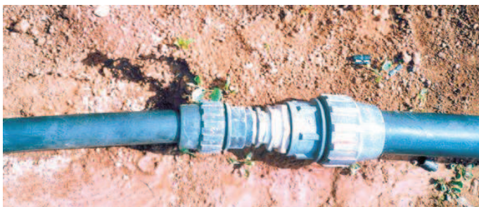
Figura 19. Tubería de polietileno utilizando racores de unión. (Centro de Formación Agraria Viñalta, 2015).
