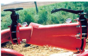
Válvula de compuerta a la izquierda y válvula de mariposa a la derecha
