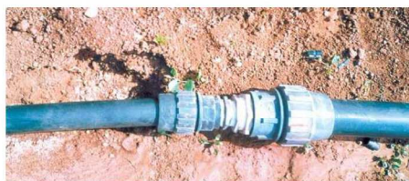
Racores de unión (cambiador de sección) en tuberías de POLIETILENO
