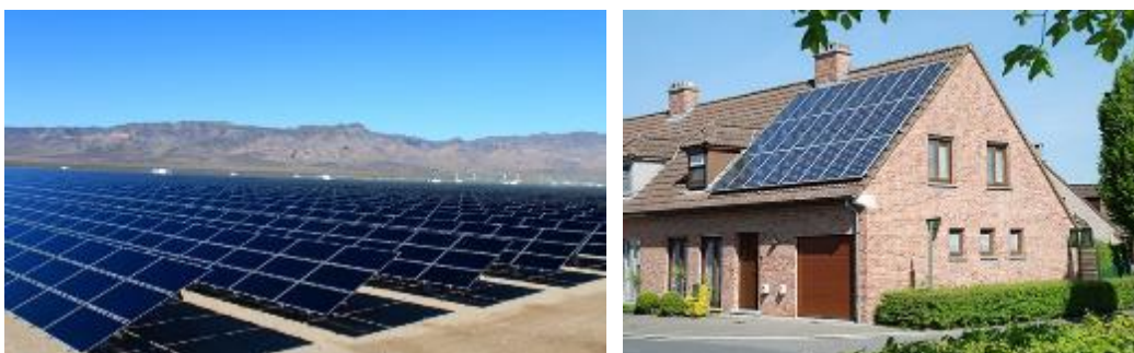
Figura 1.55. Planta fotovoltaica y paneles para autoconsumo.
