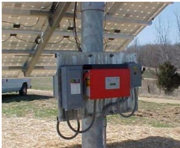
Figura 1.68. Inversor solar.
