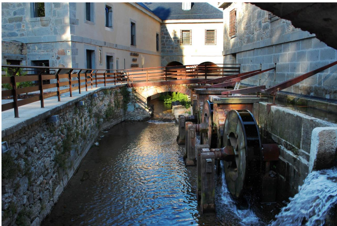
Figura 4.2. Casa de Moneda rehabilitada
