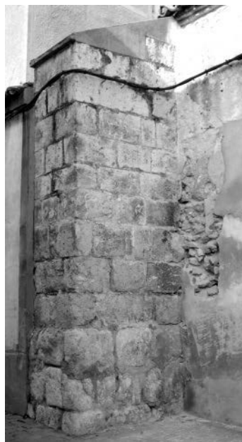
Fig. 6. Estribo suroccidental de la antigua iglesia de San Pedro, situado en el hastial oeste. Bartolomé de Cubillas y Hernando del Río. 1564. Íscar (Valladolid)
