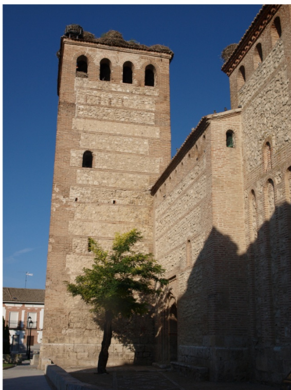
Fig.121_ Iglesia de San Juan, Mojados. Campanario con espacio superior defensivo, resuelto con galería de arcos que lo integra en el edificio.
