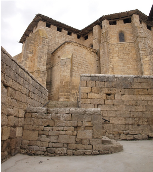
FIG. 170_Iglesia de Santiago . Castrillo de Murcia. Vista de la cabecera y del crucero, sobre los que se eleva una galería almenada con fines defensivos.
