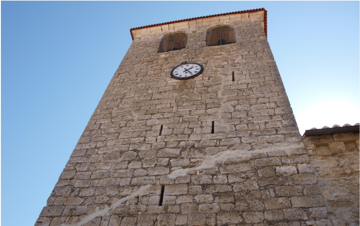
FIG. 127_ Iglesia de San Esteban, Tabanera del Cerrato. Campanario con saeteras repartidas por todas sus fachadas.
