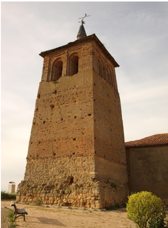
Fig 111_Iglesia de Villamoratiel de las Matas (León). La torre situada exenta a escasos centímetros de la iglesia, con el acceso por el espacio que las separa.
