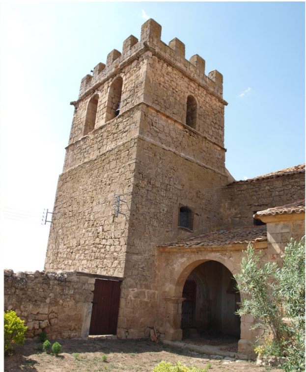
Fig.116_Iglesia de Sº Dº de Silos, Señuela. Torre-campanario con azotea almenada. Destaca la presencia de gárgolas con formas animalescas.
