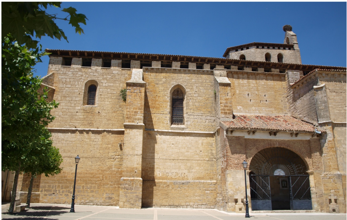
FIG. 172_Iglesia de San Cornelio y San Cipriano, en la localidad de San Cebrián de Campos (Palencia). Remate almenado sobre los muros de la iglesia, con posible uso defensivo, aunque la escasa altura de la cámara generada entre las bóvedas y la cubierta ponen en duda esta teoría.
