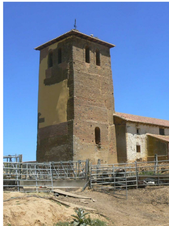
Fig.99_ Iglesia La Asunción, Nava de los Oteros. Torre-campanario situada a los pies del templo, con acceso exterior en altura
