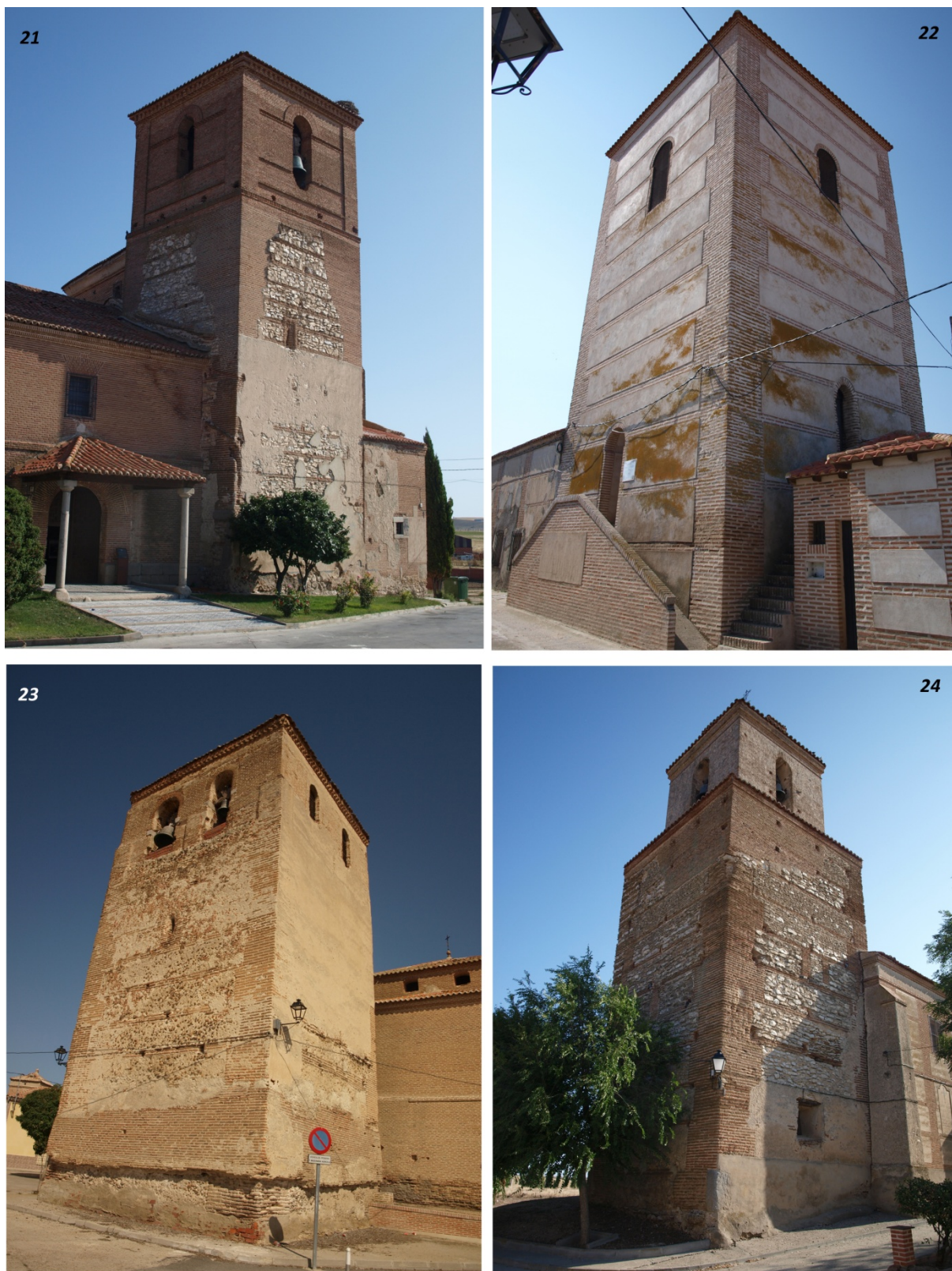
FIG.21,22,23,24_ Iglesias de Sinlabajos, San Esteban de Zapardiel, Castellanos de Zapardiel, Villanueva del Aceral. Iglesias fortificadas con torres defensivas adaptadas para su uso como campanarios. Construcciones de cajones de mampostería encintadas con ladrillo, de gruesos muros y camaras interiores abovedadas..
