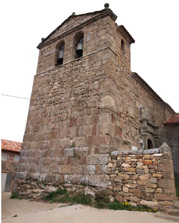
FIG.43_Iglesia de Conquezuela (Soria). Restos en los pies de la iglesia de aparejo califal, pertenecientes a una fortificación anterior
