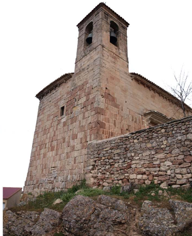
FIG.44_Iglesia de Mezquetillas (Soria). Restos en los pies de la iglesia de aparejo califal, pertenecientes a una fortificación anterior
