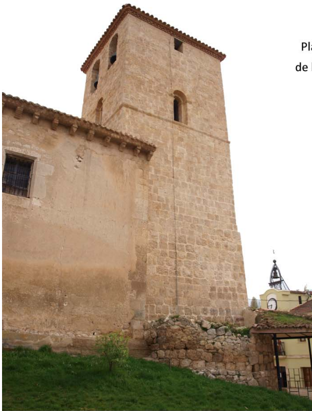
FIG.41_Iglesia de Miño de San Esteban (Soria). Restos de una atalaya musulmana circular en la base de la torre de la iglesia
