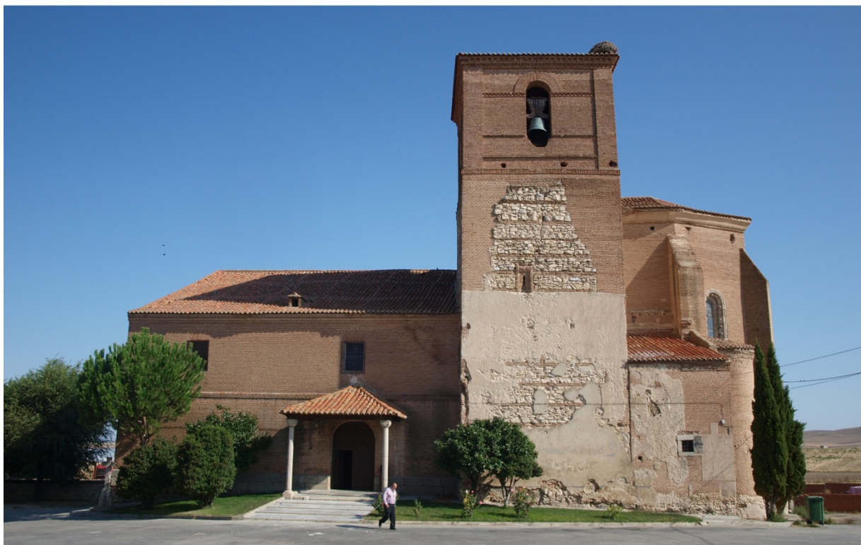
Fig. 108_Iglesia de San Pelayo, Sinlabajos (Ávila).
