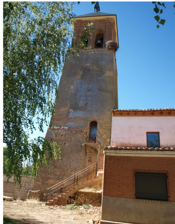
Fig.97_ Iglesia parroquial de Cabreros del Río (León) Torre situada a los pies con acceso elevado exterior
