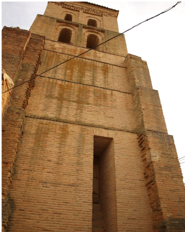
Fig.96_ Iglesia de San Pedro, Vallecillo (León) Acceso elevado exterior situado en la fachada norte
