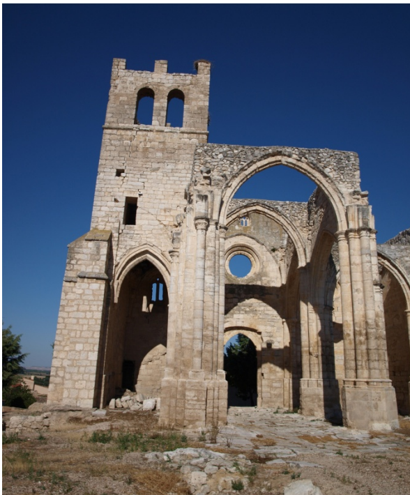
Fig.117_Iglesia de Santa Eulalia, Palenzuela. Torre almenada sobre el último tramo de la nave sur. Se observa el hueco que daba acceso a las bóvedas
