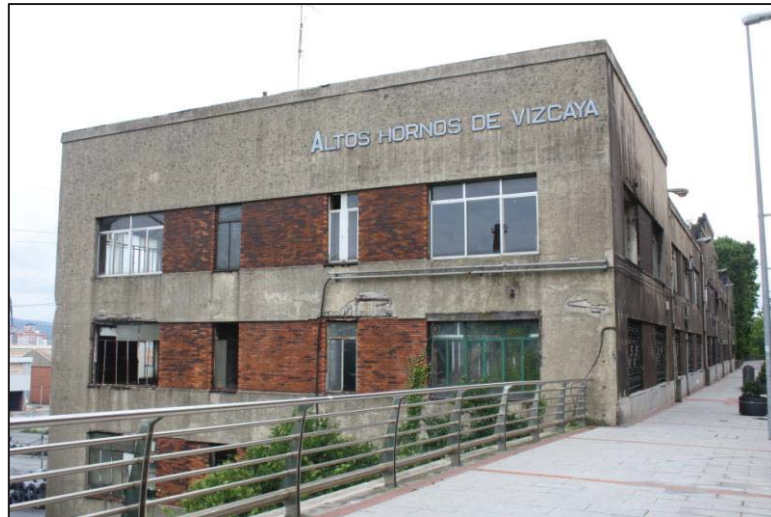
Figura 8: Edificio abandonado de la empresa Altos Hornos de Vizcaya, en Sestao. Mayo 2015. Imagen del autor.
