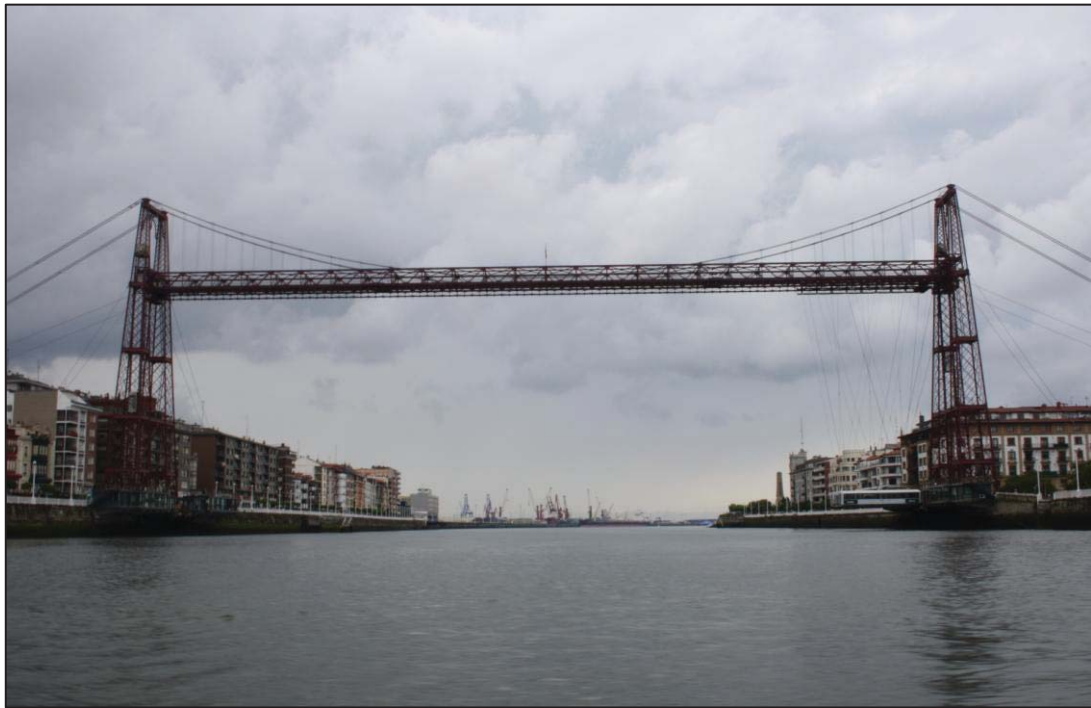
Figura 42: Puente de Vizcaya sobre la Ría del Nervión. Junio 2015. Imagen del autor.
