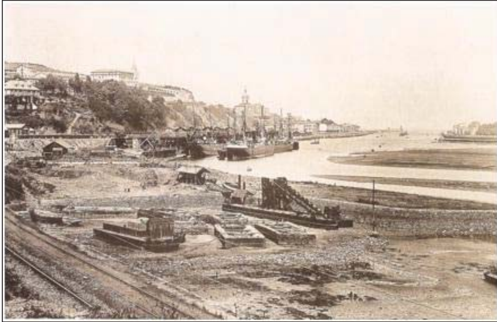
Figura 25: Imagen de la Ría anterior a la construcción del Puente de Vizcaya.
