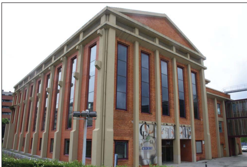
Figura 20: Fotografía exterior del Pabellón Ilgner. Mayo 2015. Imagen del autor.
