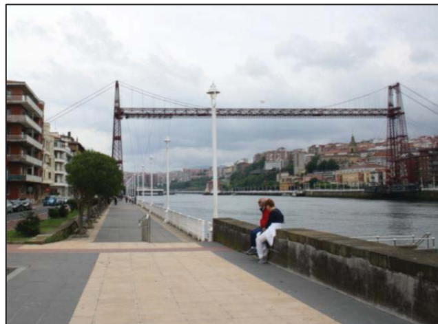
Figura 39: Paseo peatonal y de bicicletas en Las Arenas. Junio 2015. Imagen del autor.
