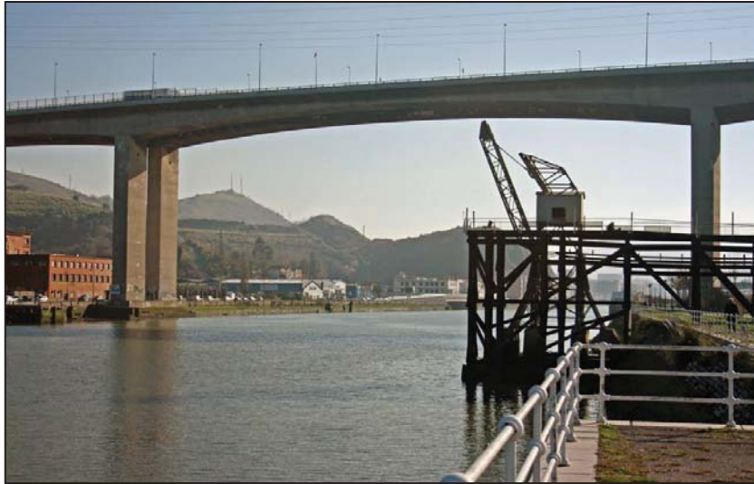
Figura 4: Antiguo cargadero de mineral de la Compañía Franco Belga. Tomada de http://www.panoramio.com/photo/65441341
