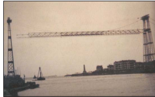
Figura 30: Distintos momentos de la fase de reconstrucción del puente. Tomados de Pérez Trimiño, Alfredo (pp. 51-52).
