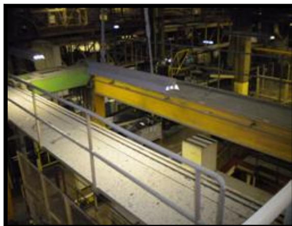
Ilustración 18. Puente grúa. (Fuente: Michelin)
