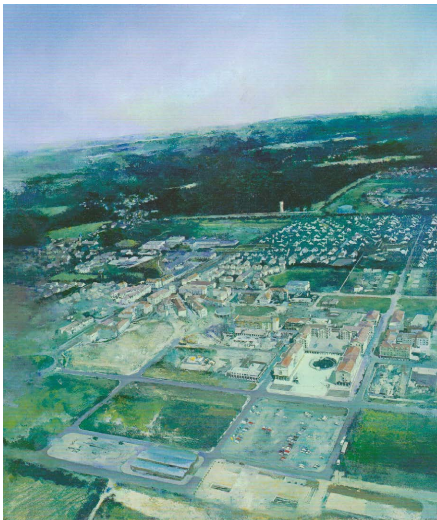
Fig.2. Image à l’aquarelle commandée par l’EPA Marne pour représenter « le cœur de la ville ». Au milieu la « Grand’Place » de Manolo Nunez.
