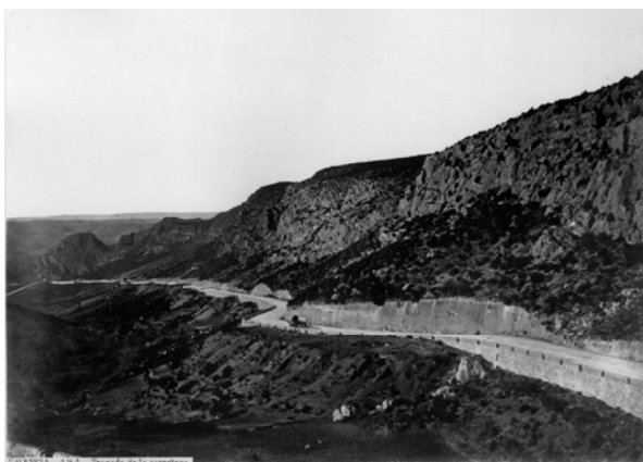
Fig.1.- Carretera de Valencia construida por Lucio del Valle en 1853. La carretera del XIX es cercana al terreno y territorio, con acceso a las parcelas colindantes y escaso tráfico hipomóvil. Fuente: Francisco Javier Rodríguez Lazaro y José María Coronado Tordesillas -eds.- (2003): «Obras Públicas de España. Fotografías de J. Laurent, 1858 – 1870», Ciudad Real: Univ. de Castilla – La Mancha.
