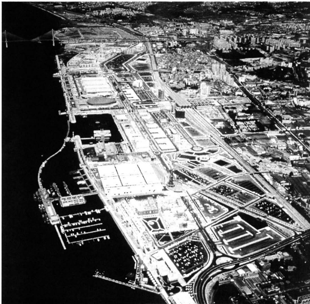
FOTOGRAFIA AÉREA DA SITUAÇÃO ACTUAL
