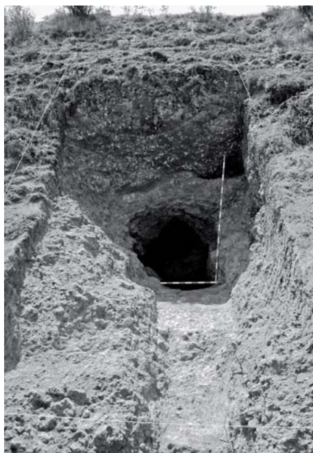
Fig. 4. Spiramen lateral del acueducto de Uxama desde el exterior. Obsérvese la rampa de acceso tallada también en la roca (Foto de A. Balado).
