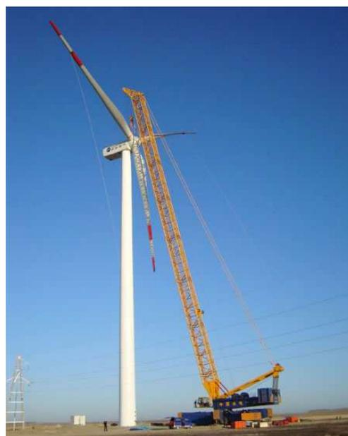
*Fig.3.18. Aerogenerador con torre tubular de acero.*
