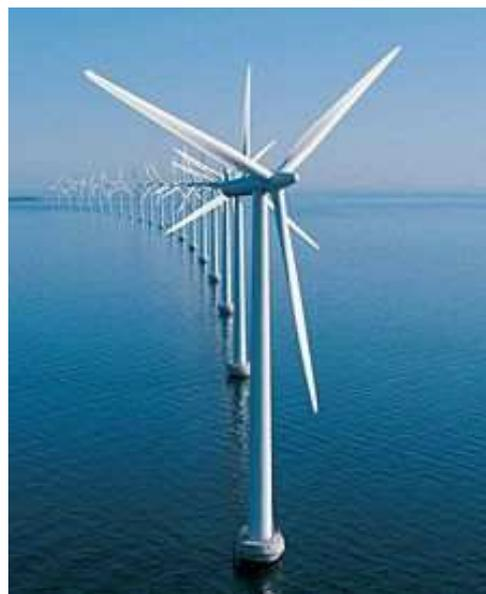
*Fig.3.12. Aerogenerador con rotor Tripala.*
