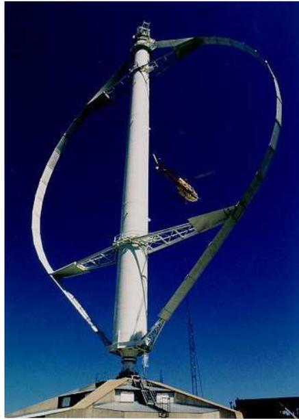
*Fig.3.9. Aerogenerador con rotor Darrieus.*
